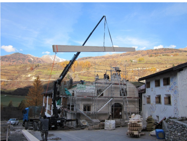
Bild 14: Unmittelbar nach der Montage des Stahlträgers konnten die Zimmerleute mit der Montage des Dachstuhls beginnen
