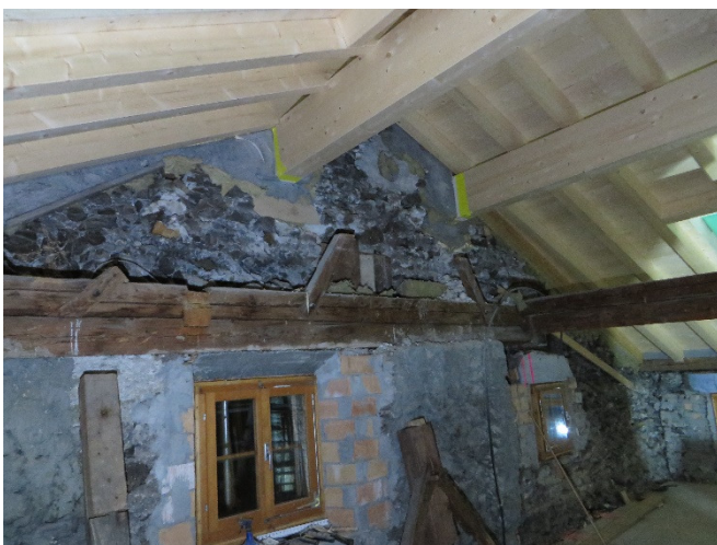
Bild 20: Der fertige Dachstuhl im Bereich der Zimmer Ajüz und Lischana. Die Zwischenwand ist demontiert und wird verschoben. Durch grosse Dachflächenfenster erhalten beide Zimmer mehr Licht.
