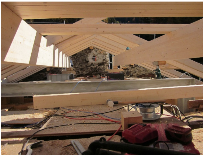
Bild 18: Dank der Konstruktion mit zwei Pfetten und überblatteten Sparren bleibt der Firstbereich frei begehbar.
