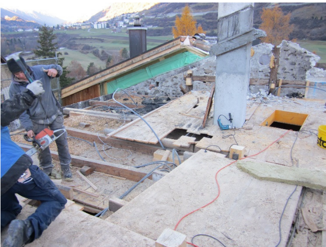
Bild 12: Die entfernte Dachkonstruktion zeigte das Haus in einer ungewohnten Perspektive
