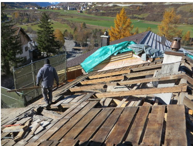
Bild 8: Die Dachkonstruktion nach Entfernen der Eternitplatten und der Blechabdeckung.
