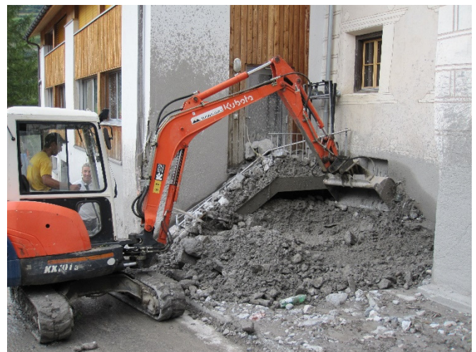
Bild 5:..wurde sofort von einem Kleinbagger geräumt.
