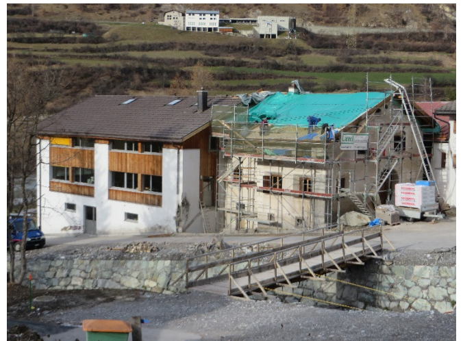
Bild 21: Noch fehlen die Ziegel, aber Ende 2015 ist das Dach isoliert und winterfest abgedeckt.
