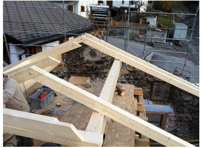
Bild 17: Schon bald ist die Form des neuen Dachstuhls zu erkennen.
