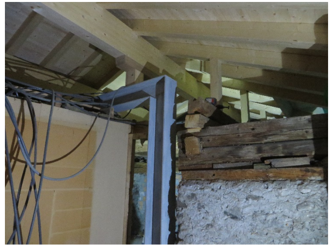
Bild 19: Im Zimmer Madlain wurde die Decke geöffnet, was den Blick zum neuen Dachstuhl freigibt. In Bildmitte ist der neue Stahlträger sichtbar.
