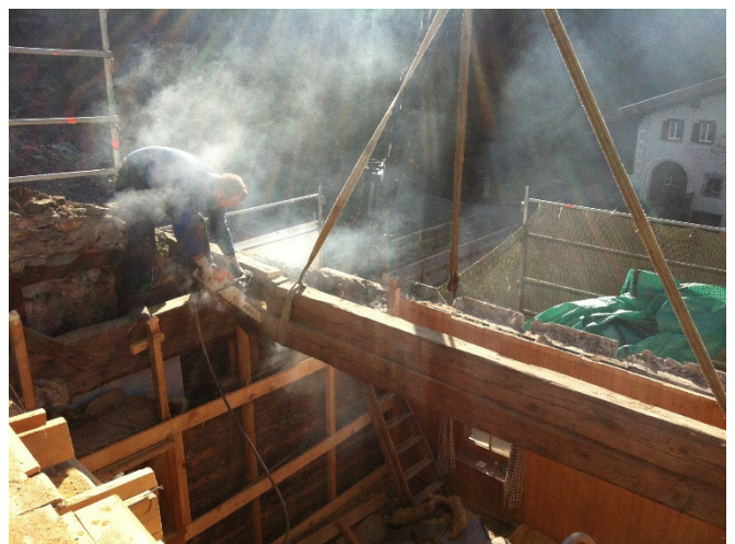
Bild 9: Überflüssige Konstruktionsteile konnten entfernt werden.
