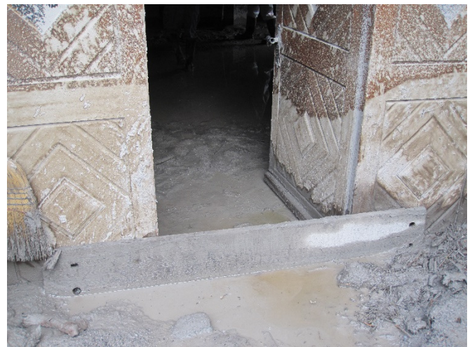
Bild 7: Die Haus-Eingangstüre hat auch stark
