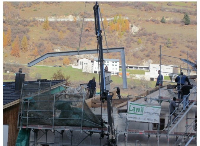
Bild 13: Ein massiver Stahlträger wurde mit einem Lastwagenkran an seinen Platz in der Dachmitte gehievt und montiert.
