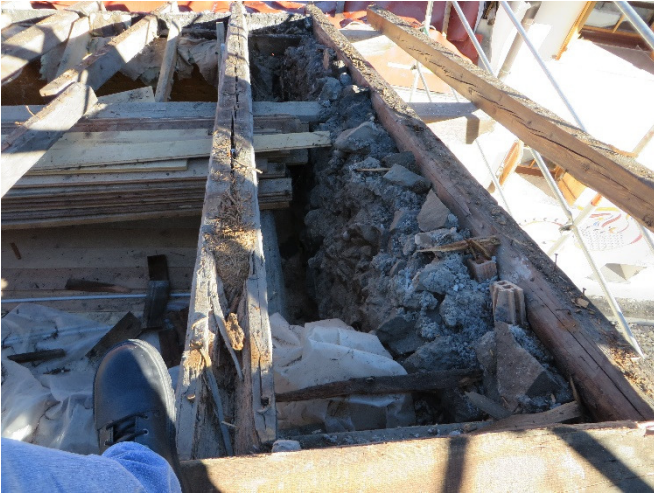
Bilder 10 und 11: Halb zerfallene oder zusammengesetzte Sparren, morsches Holz, viel Luft und die Mauer mit viel lockeren Steinen bilden keine vertrauenswürdige Grundlage für dauerhafte konstruktive Verbesserungen.
